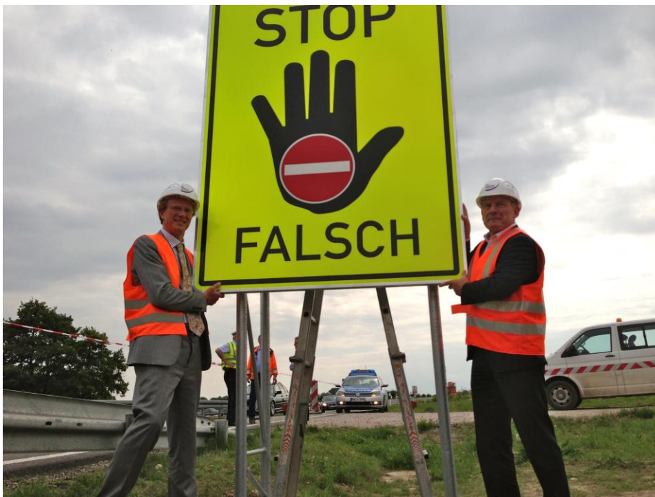
Signalwirkung beabsichtigt: Verkehrsminister Herrmann und Via Solutions Südwest-Geschäftsführer Judet bei der Montage einer Falschfahrerwarntafel an der A5-Anschlussstelle Achern
